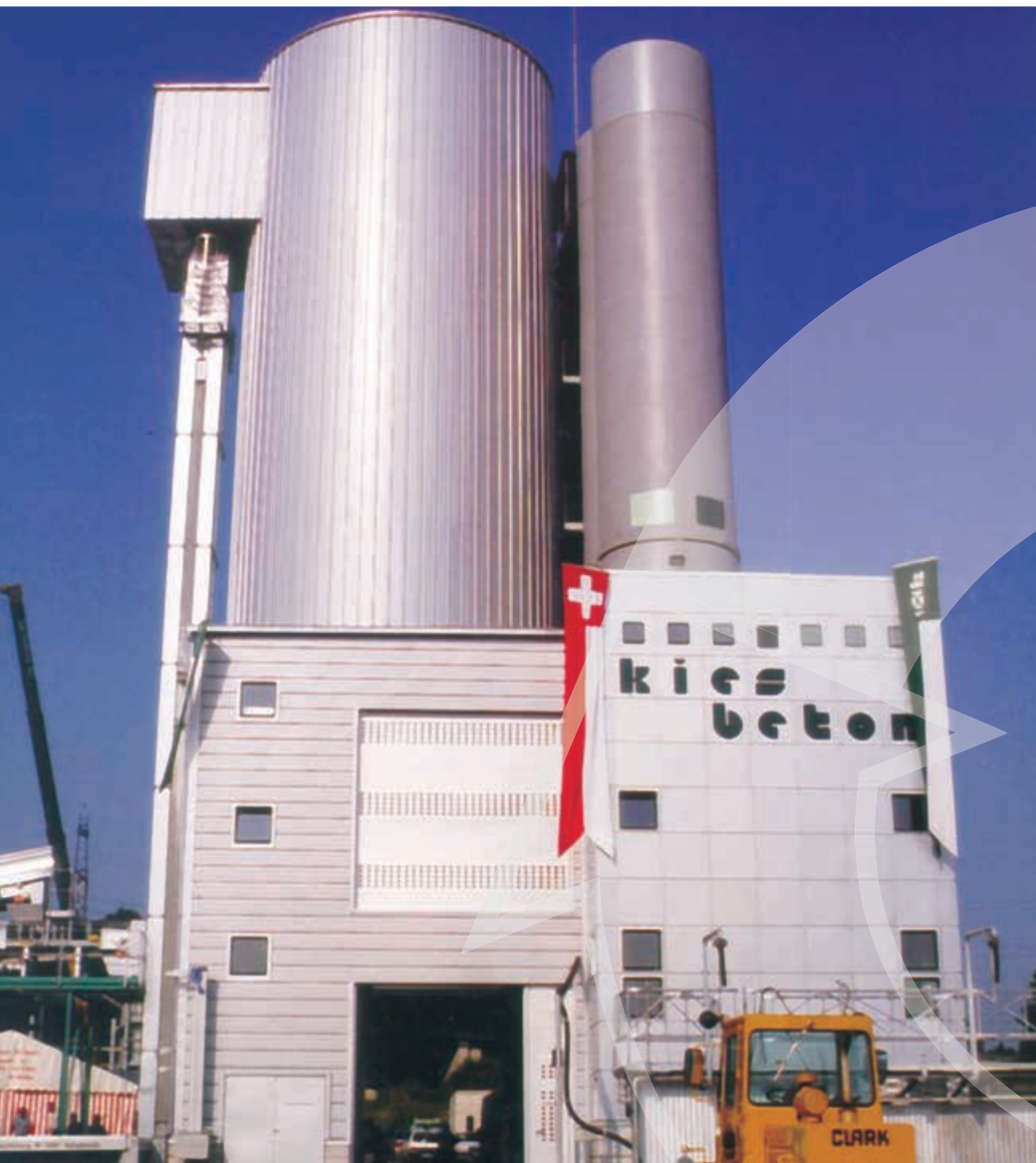
Turmanlage mit 520 m 3 Fassungsvermögen
